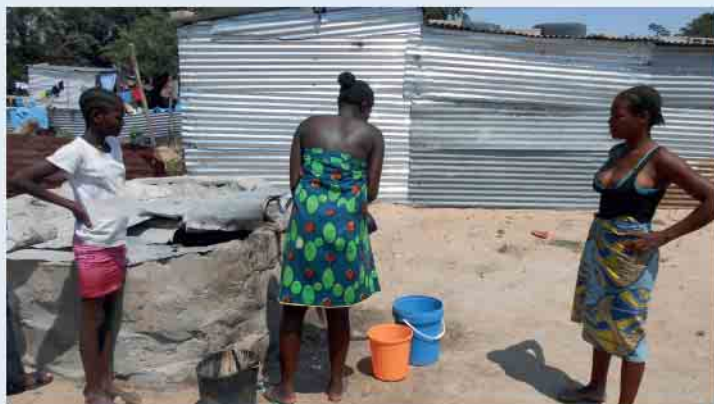
Um poço eendungu protegido com uma tampa de chapa de zinco
